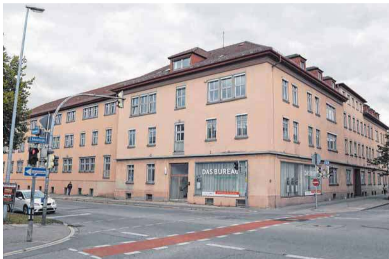
Der rechte Flügel des alten EnBW-Gebäudes wird abgerissen. Aus dem Neubau und dem alten Gebäudeteil werden bis Frühjahr 2019 ein Hotel sowie Wohnungen.
